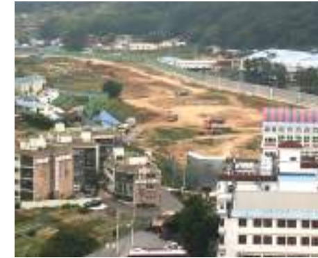
| 양산 교통 부지 조성공사
