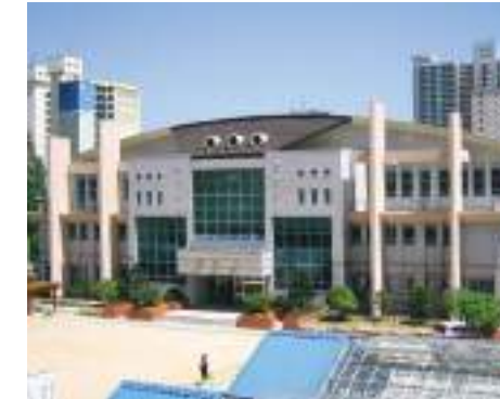
| 부산 원예고등학교 다목적강당 증축공사
