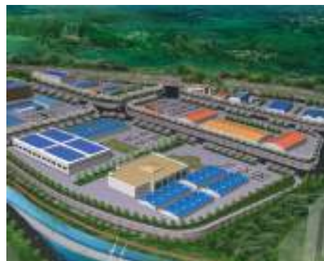
| 에코 장안 일반산업단지 조성공사 214,300㎡ (64,825평)
